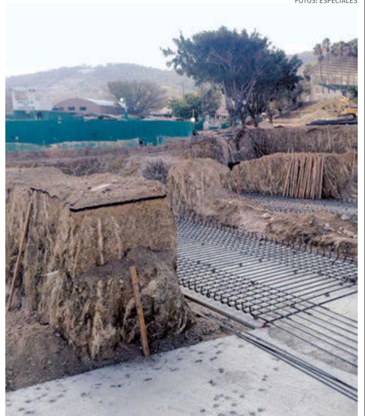
Se trabaja las 24 horas en la edificación del recinto de Chiapas
